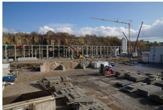
in den toten Saaleboden eingebracht und verfestigt. Dadurch wurde der Baugrund für die Stahlbetonstützen und die neue Mischanlage geschaffen.
